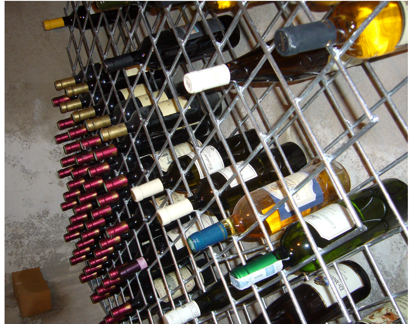
referenční příklad vinotéky - svařovaná pozinkované betonářská výztuž, průměr 6mm, velikost ok 114x114mm, nakoso
