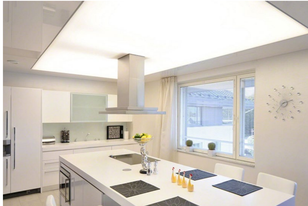
napínaný stropní podhled (kuchyně) + LED osvětlení okraje podhledu
