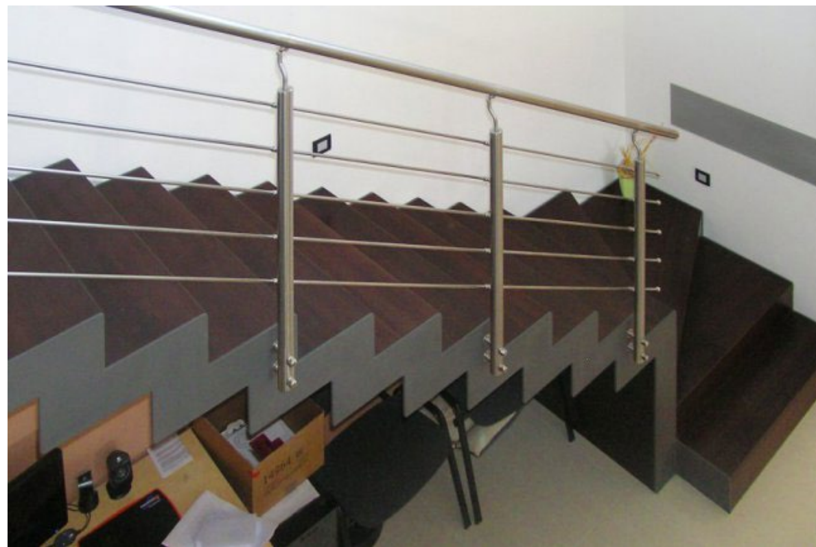
referenční příklad řešení schodiště - ocelové schodnice
