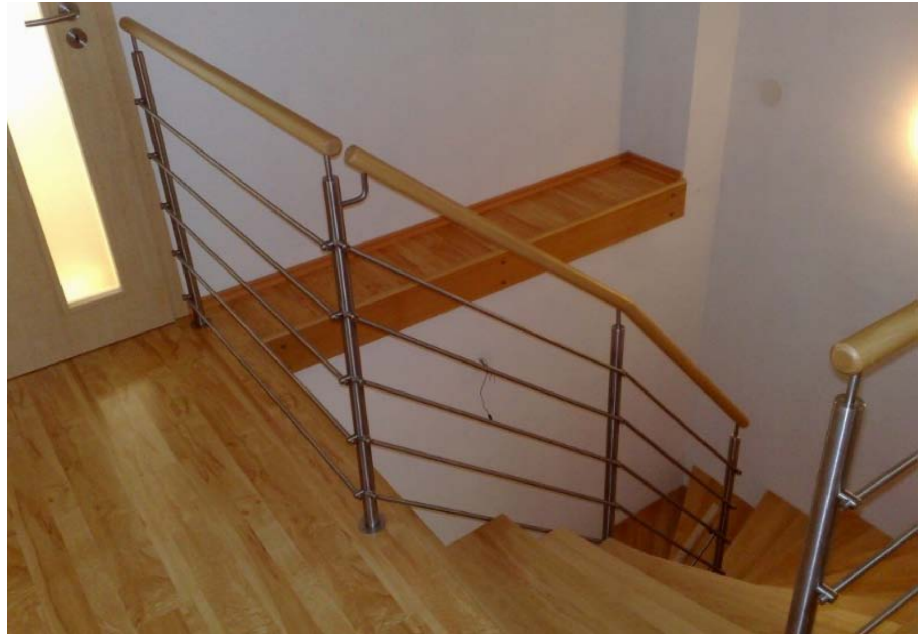
zábradlí: ocel/nerez. trubkové schodiště s dřevěným madlem, v dolní části schodiště pouze dřevěné madlo kotveno do zdi
