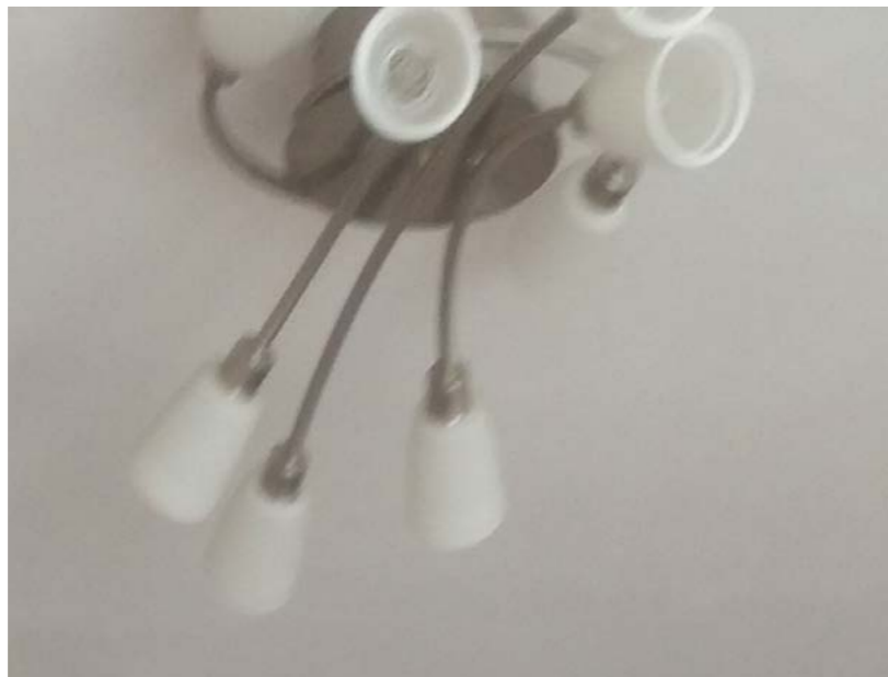
LOŽNICE stropní: stávající světlo (foto)
