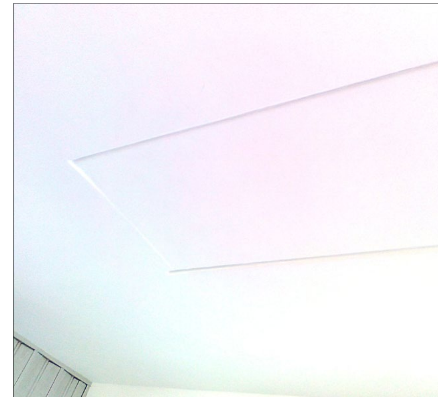
Zarovnání obdélníkového odskoku ve stropu (viz foto).
