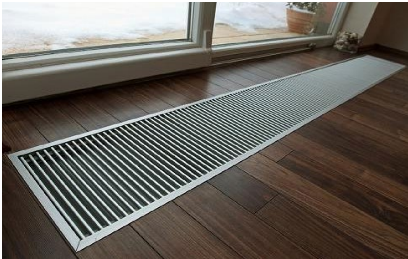
Podlahový konvektor pod oknem místo radiátoru
